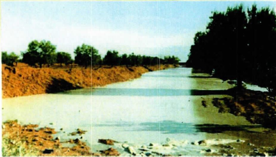
Figure 22. Système de collecte des eaux de pluie.
